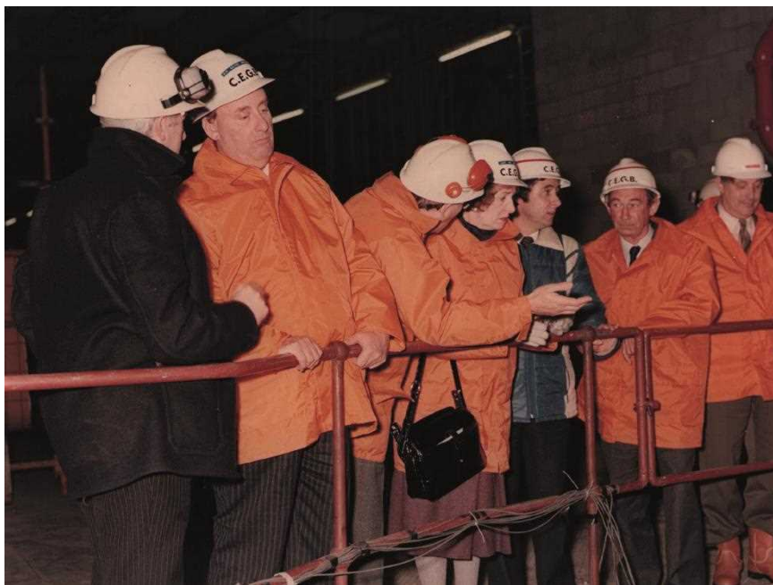
Посещение строящейся гидроэлектростанции Динорвик, Ноябрь 1982 г.
