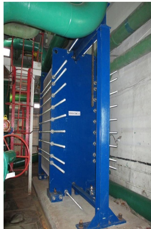
Теплообменники СОС (типа М30-FG) после модернизации
