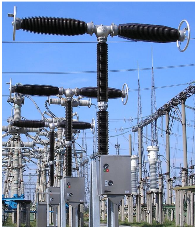
Выключатели 330 кВ (тип GL-315x, ALSTOM, Франция)
